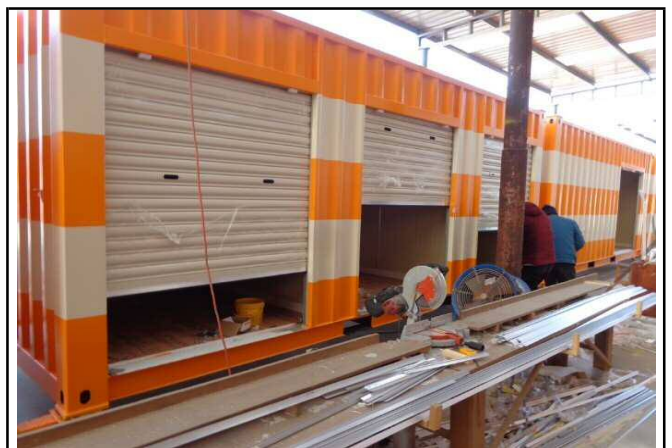
シャッター取付
